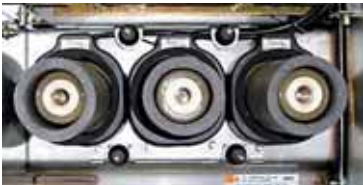
Cảm biến dòng lắp ở đầu cực RM6
